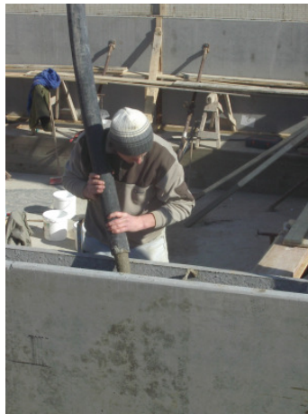
Ausbetonieren der Sandwich-elemente März 2006
