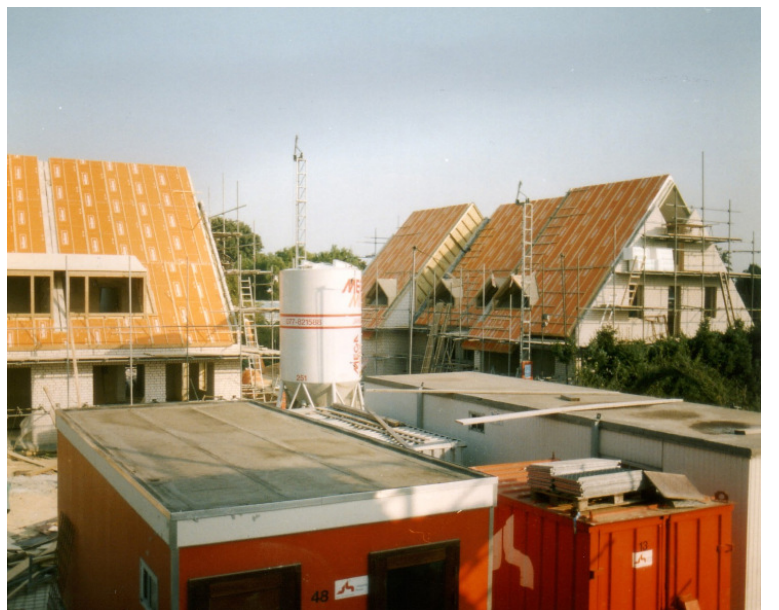
Die Dächer wurden als vorgefertigte Sandwich-Elemente auf der Baustelle montiert und die Stöße nachträglich verklebt: 20 cm Styropor-Vollsparrdämmung
