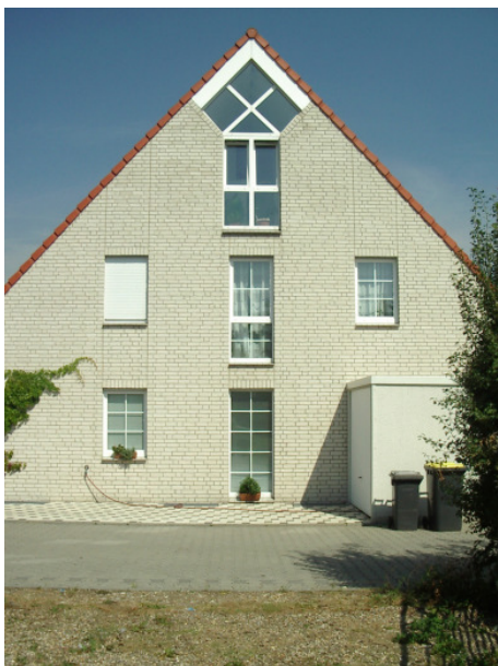
Wandaufbau von innen nach außen: 12cm KS-Planblockelemente, 12cm Kerndämmung und 10cm Klinker
