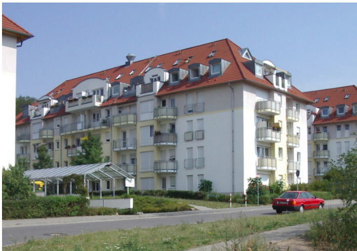
▲ Wohnanlage in Dresden – Mathias-Oeder-Straße mit Tiefgarage – Straßenfront
