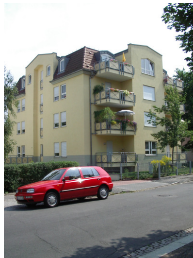
▲ Mehrfamilienhaus in Dresden, Adolfstraße - Straßenfront
