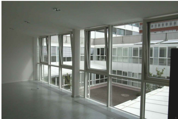
Innenecke der neuen Pfosten-Riegel-Konstruktion ►
